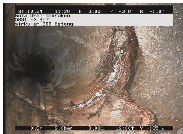
31.10.2024 10_14_49_20089a4b-72c6-42d2-9336-f398a28192b2_202410 31_103007_263.jpg, 00:00:36, 0.80m 1, Lengdeforskjøvet på 3 Kl.
