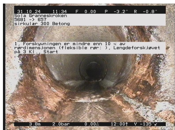
31.10.2024 10_14_49_ee6a8000-8dcd-4786-8c65-2a0d2b44ff3d_202410 31_103443_264.jpg, 00:02:10, 3.84m 1, Forskyvningen er mindre enn 10 % av rørdimensjonen (fleksible rør: ), Lengdeforskjøvet på 3 Kl., Start
