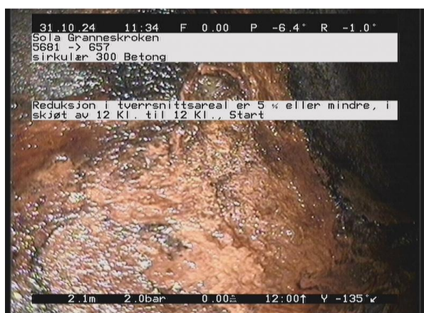
Granneskroken_5681_21228.jpg, 00:01:38, 2.12m Reduksjon i tverrsnittsareal er 5 % eller mindre, i skjøt av 12 Kl. til 12 Kl., Start
