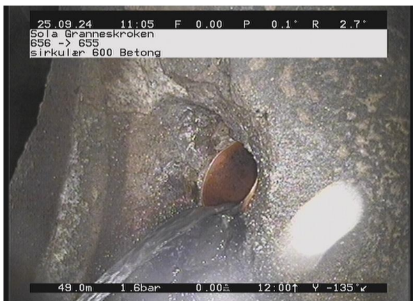
Granneskroken_656_10299.jpg, 00:06:24, 49.00m Tilkopling. Innhugget tilkobling på 3 Kl.
