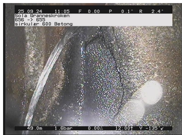
Granneskroken_656_6111.jpg, 00:06:24, 49.00m Rørbiten har løsnet eller mangler, utstrekning 2 - 4 timer, kompleks av 3 Kl. til 6 Kl.
