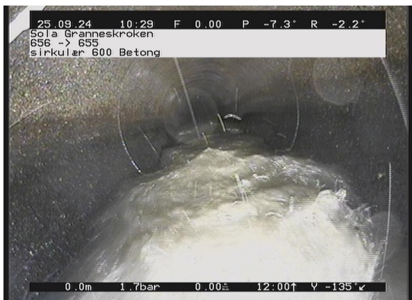
Granneskroken_656_22166.jpg, 00:00:15, 0.01m Korrosjon/Slitasje 2, I betongrør er tilslagsmaterialet tydelig blottlagt eller rustutfelling av 12 Kl. til 12 Kl., Start
