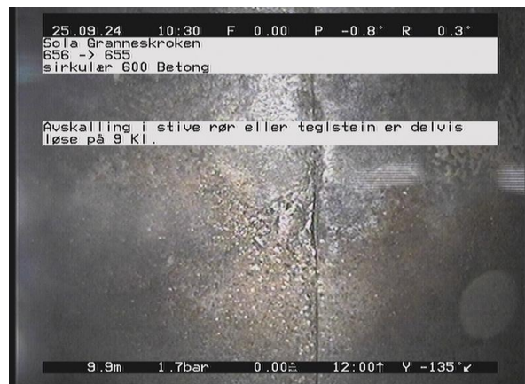
Granneskroken_656_52849.jpg, 00:01:16, 9.96m Avskalling i stive rør eller teglstein er delvis løse på 9 Kl.
