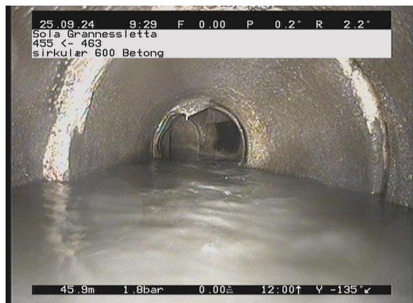
Grannessletta_455_25373.jpg, 00:05:44, 45.94m 2, Lengdeforskyvning (stive rør), Lengdeforskjøvet på 9 Kl.
