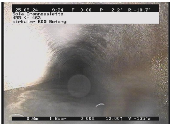
Grannessletta_455_11486.jpg, 00:00:21, 0.66m Korrosjon/Slitasje 2, I betongrør er tilslagsmaterialet tydelig blottlagt eller rustutfelling av 12 Kl. til 12 Kl., Start
