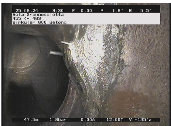
Grannessletta_455_12140.jpg, 00:06:19, 47.53m Reduksjon i tverrsnittsareal er mellom 5 - 15 %, utfelling av 11 Kl. til 1 Kl.
