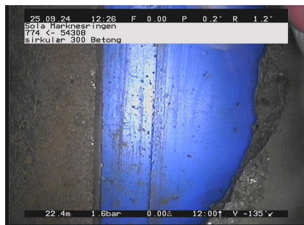
Marknesringen_774_25808.jpg, 00:04:51, 22.46m Punktreparasjon. Reparert hull på 12 Kl. / Med plastbit.
