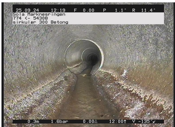
Marknesringen_774_22351.jpg, 00:00:19, 0.30m Korrosjon/Slitasje 2, I betongrør er tilslagsmaterialet tydelig blottlagt eller rustutfelling av 12 Kl. til 12 Kl., Start
