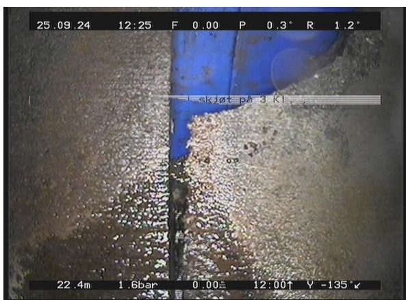
Marknesringen_774_46992.jpg, 00:04:38, 22.46m Innsig: Rennende vann, i skjøt på 3 Kl. ,
