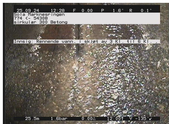
Marknesringen_774_58167.jpg, 00:06:45, 25.55m Innsig: Rennende vann, i skjøt av 3 Kl. til 6 Kl. ,
