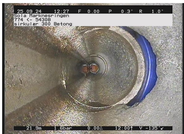
Marknesringen_774_6946.jpg, 00:04:51, 22.46m Punktreparasjon. Repartert hull på 12 Kl. / Med plastbit.
