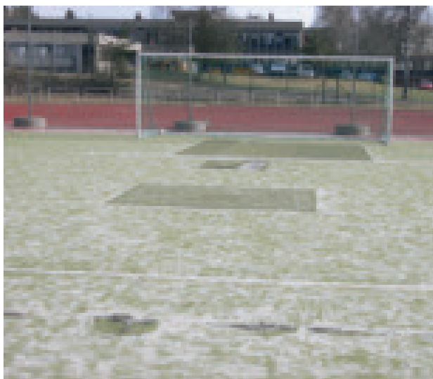
Utslitt dekke med åpne skjøter og felt
