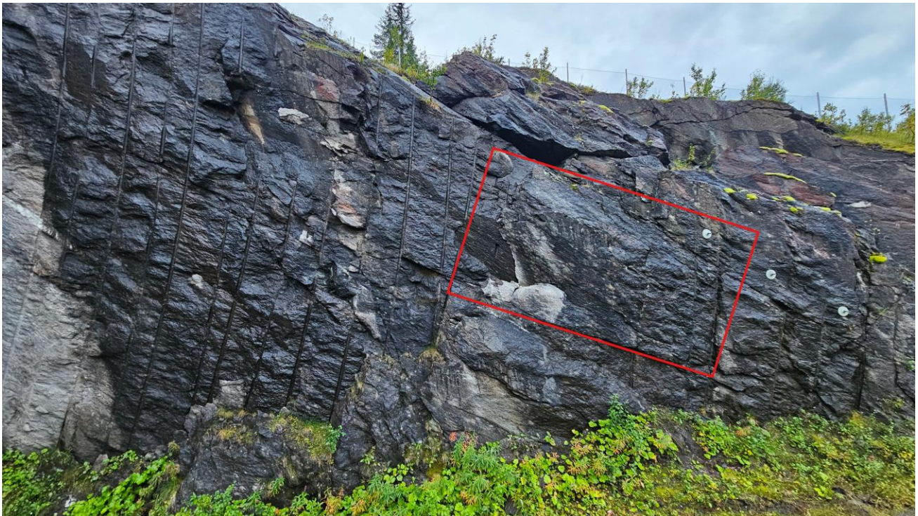
Foto 7. Forskjæring øst. Løst flak på ca. 0,5 m 3 som må renskes.
