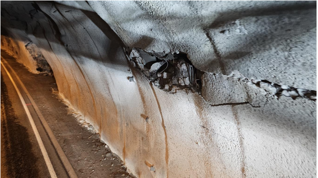
Foto 10. Pel 110 h. vegg. Hull i PE-skum, må tettes.
