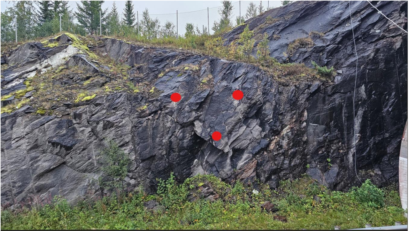
Foto 6. Forskjæring vest. Avløst blokk. Sikres med 3 stk. 3 m bolter. Røde prikker markerer bolteplassering.
