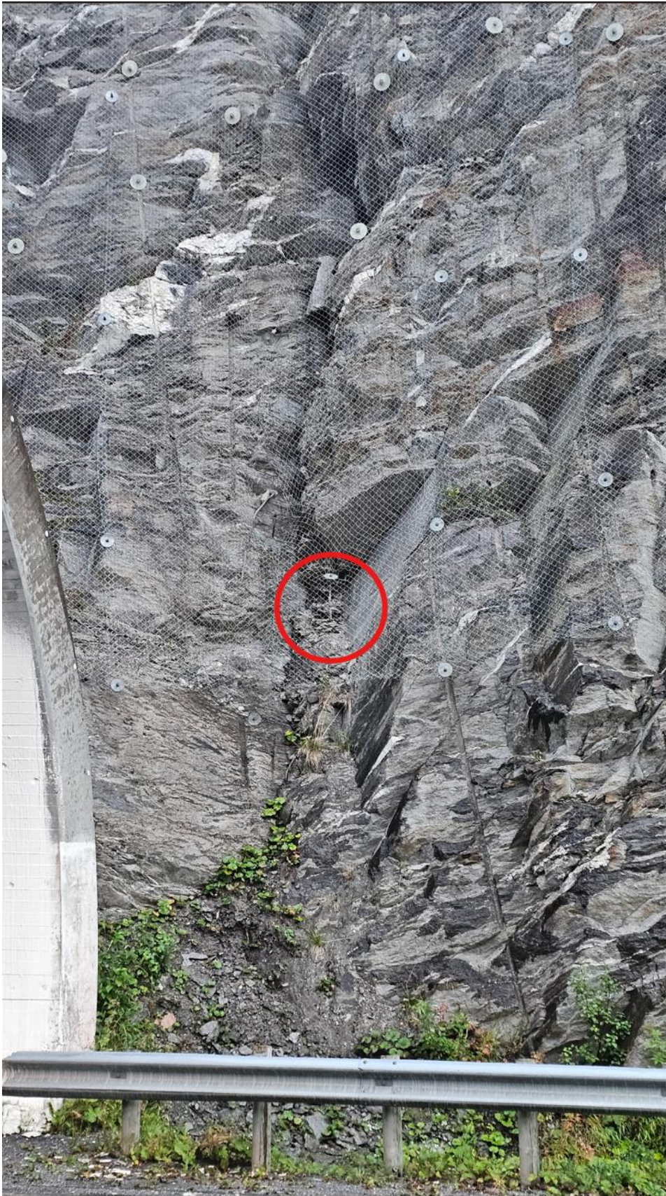
Foto 3. Løsnet festebolt i forskjæring øst, ved siden av portal. Må repareres.
