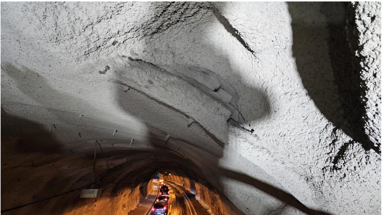
Foto 11. Pel 125 høyre heng. Åpning mellom brannsikret PE-skum og sprøytebetong. Må tettes med sprøytebetong.
