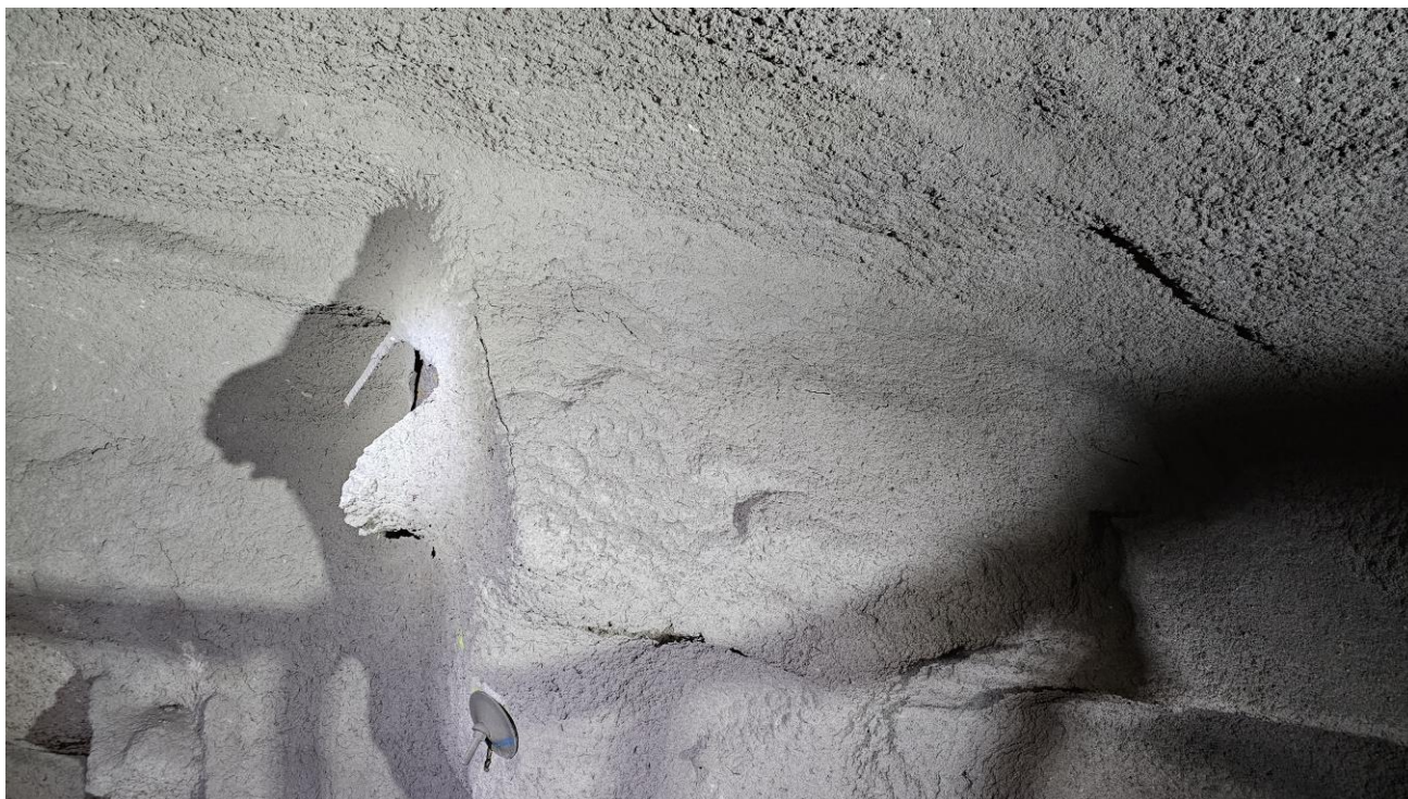
Foto 12. Pel 160. Eksempel på dårlig heft mellom berg og sprøytebetong. Rensk og påføring av ny sprøytebetong må utføres mellom pel 158-164.
