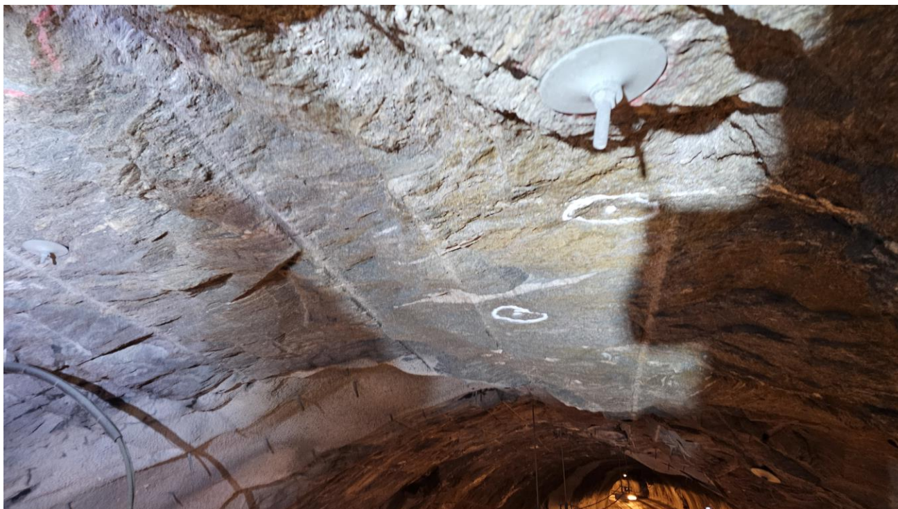
Foto 8. Pel 24 h. Heng. Tidligere anviste bolter ikke montert. 2 stk. 2,4 m bolter må monteres.
