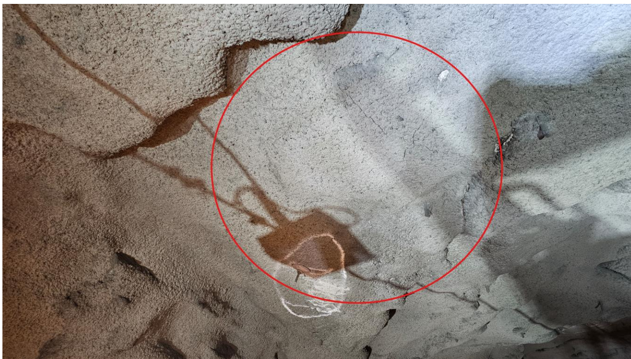
Foto 13. Pel 174. Område med bom og riss i sprøytebetong. Har blitt større siden forrige hovedinspeksjon. Må renskes og påføres ny sprøytebetong.
