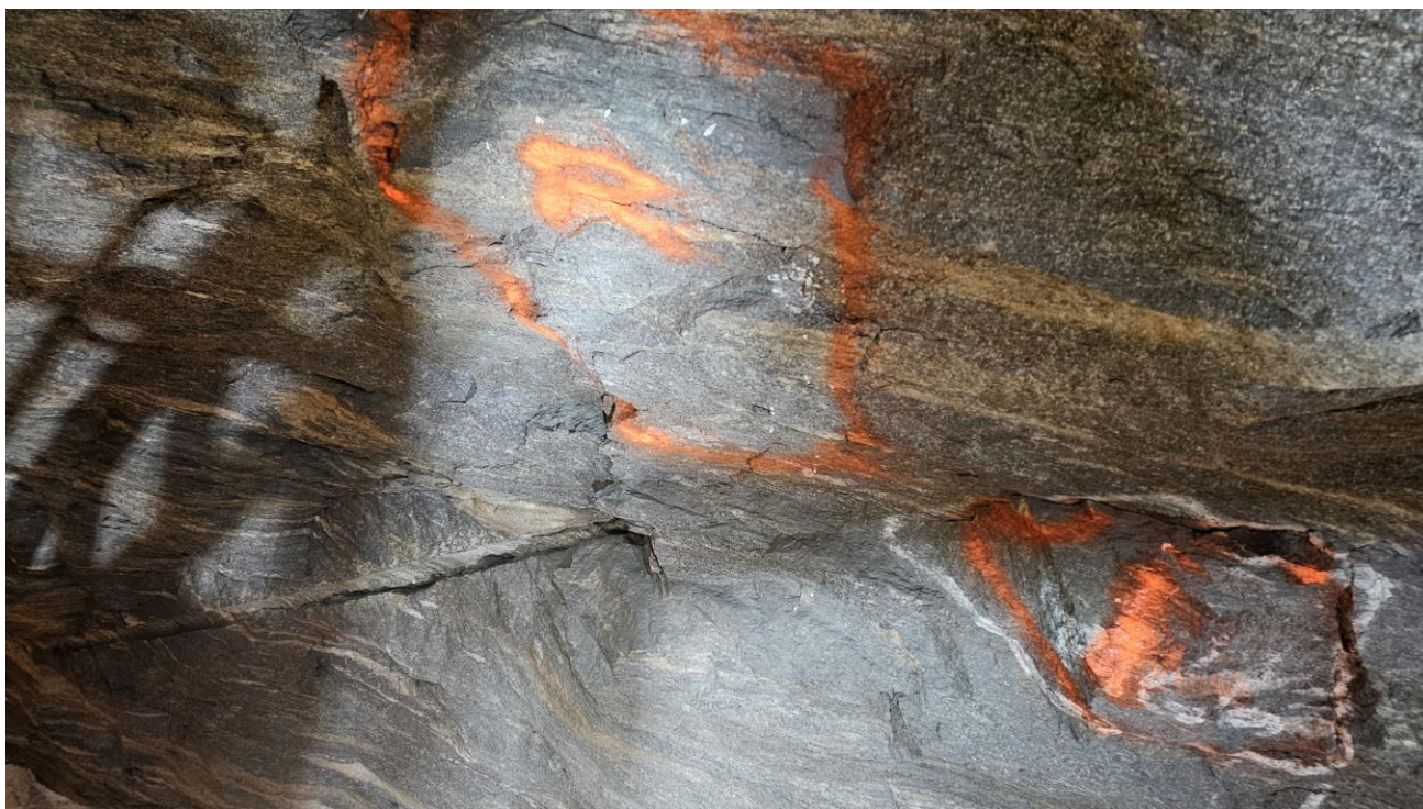
Foto 9. Pel 26 h. heng. 2 stk. avløste blokker. Markert for rensk.
