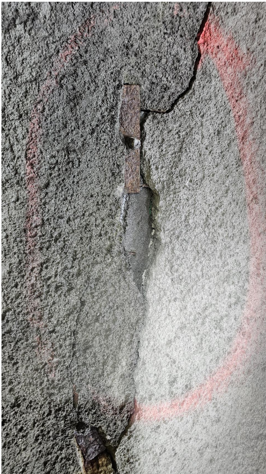
Foto 14. Pel 301. Riss mellom PE-skum og portal som må fuges.
