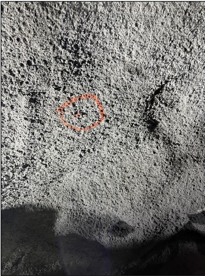
Foto 4. Pel 36 h. side, bom i sprøytebetong, anbefales boltesikres med 1 stk. 2,4 m bolt.
