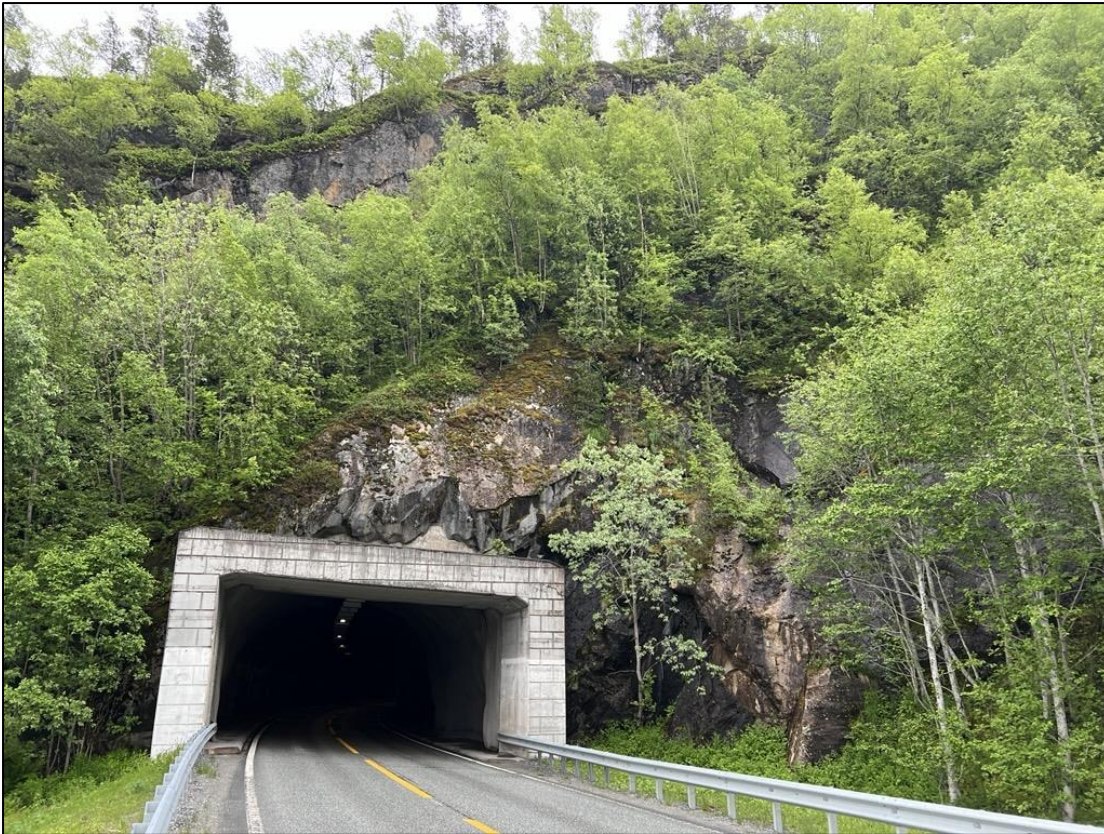
Foto 2. Oversikt portal vest. Det anbefales å inspisere naturlig skråning i overkant av tunnelportal når det ikke er blader på trærne for å få en bedre oversikt over strukturer i berget.
