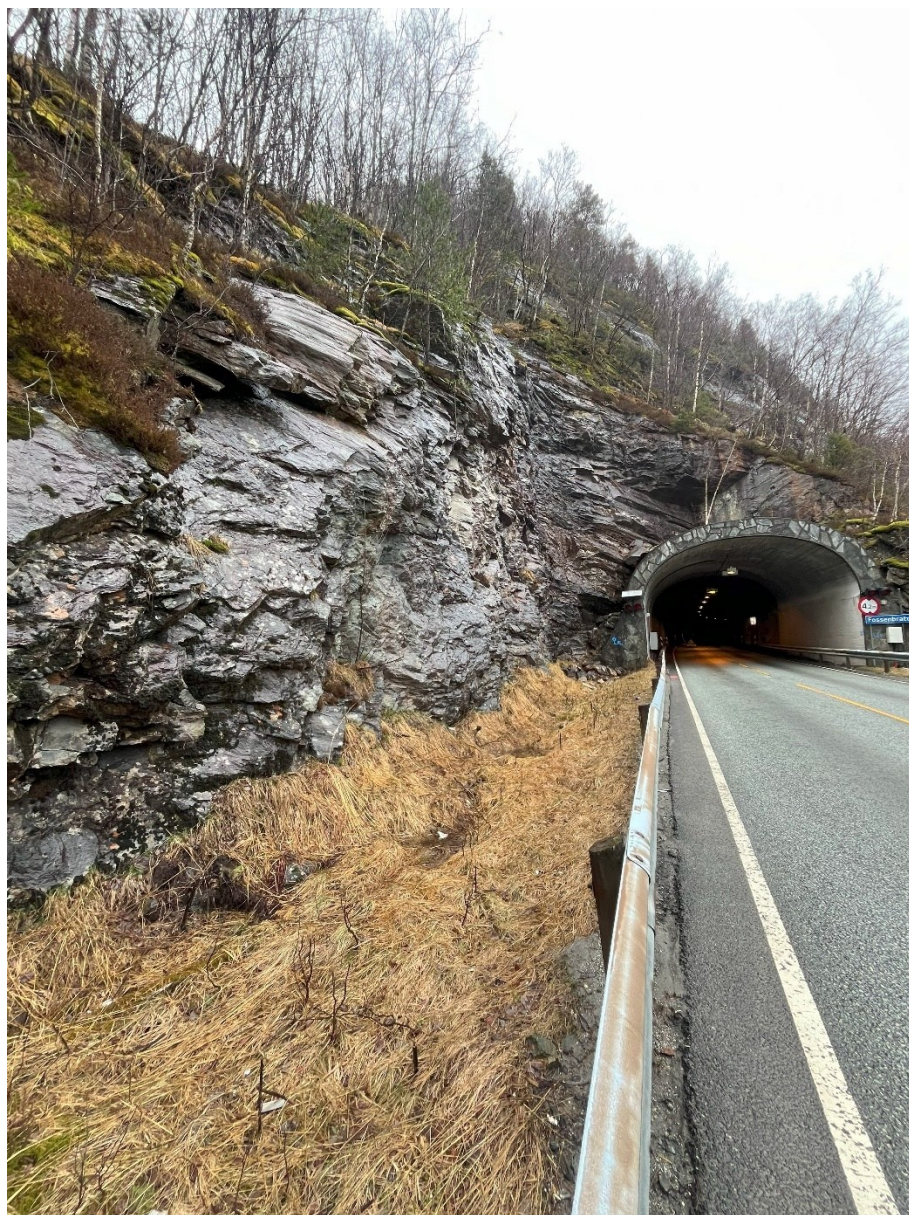
Vedlegg 3: Forskjering ved tunnelportal i vest. Foto VLFK 25.03.2025
